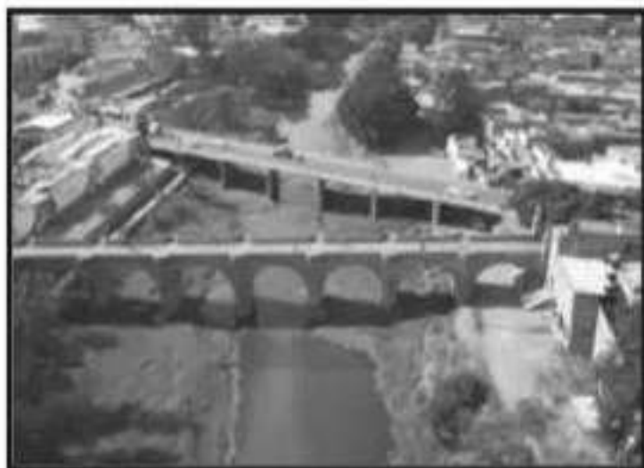
ABATEN LA PRESENCIA DE MOSQUITOS EN EL LERMA.
