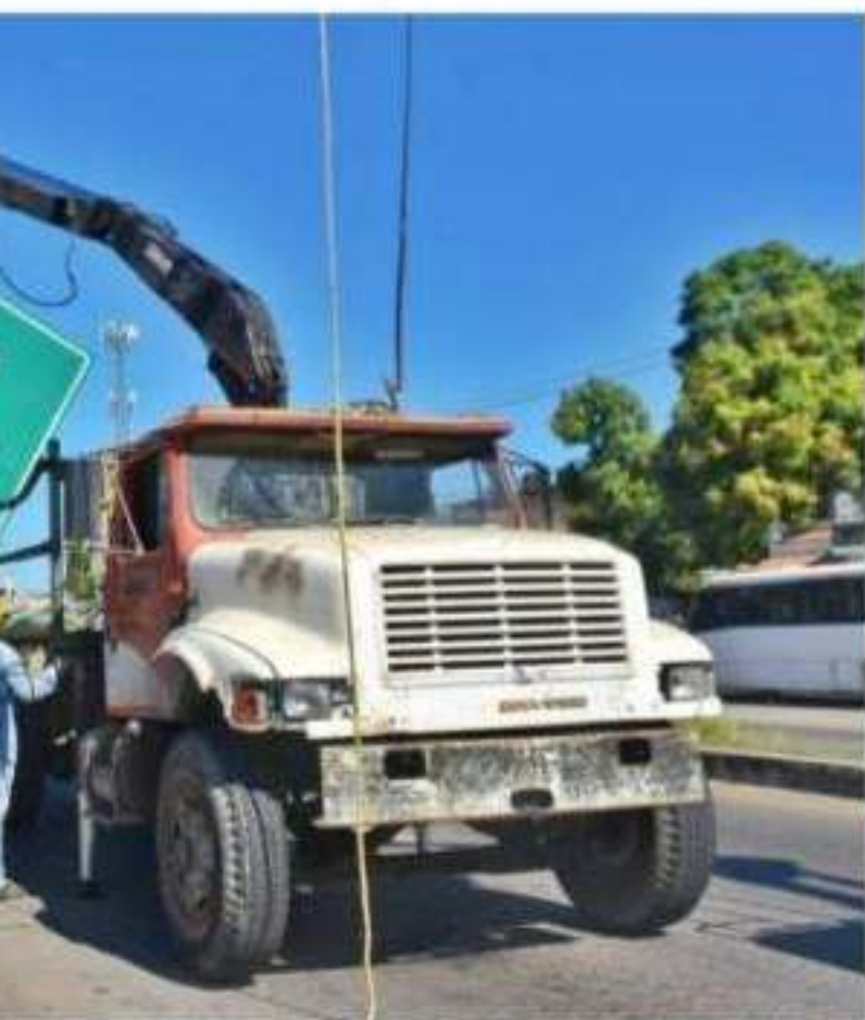
- Este domingo fue retirado un señalamiento tipo puente de la de los trabajos de la obra del distribuidor vial.
