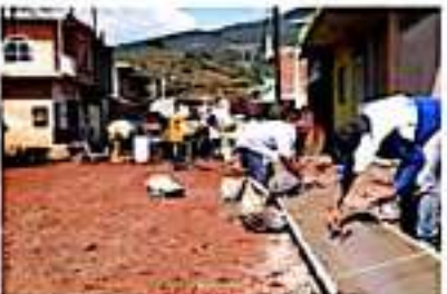
LOS REYES, MICH.- Avanza la pavimentación de la calle Lagos de Moreno.
