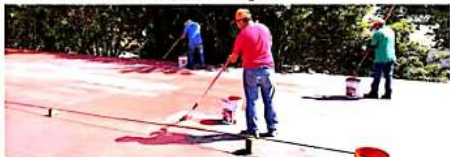
ZAMORA, MICH.- 4 aulas del Capep, situado en la colonia Villas del Magisterio, y los techos del mercado Hidalgo, están siendo objeto de impermeabilización.
