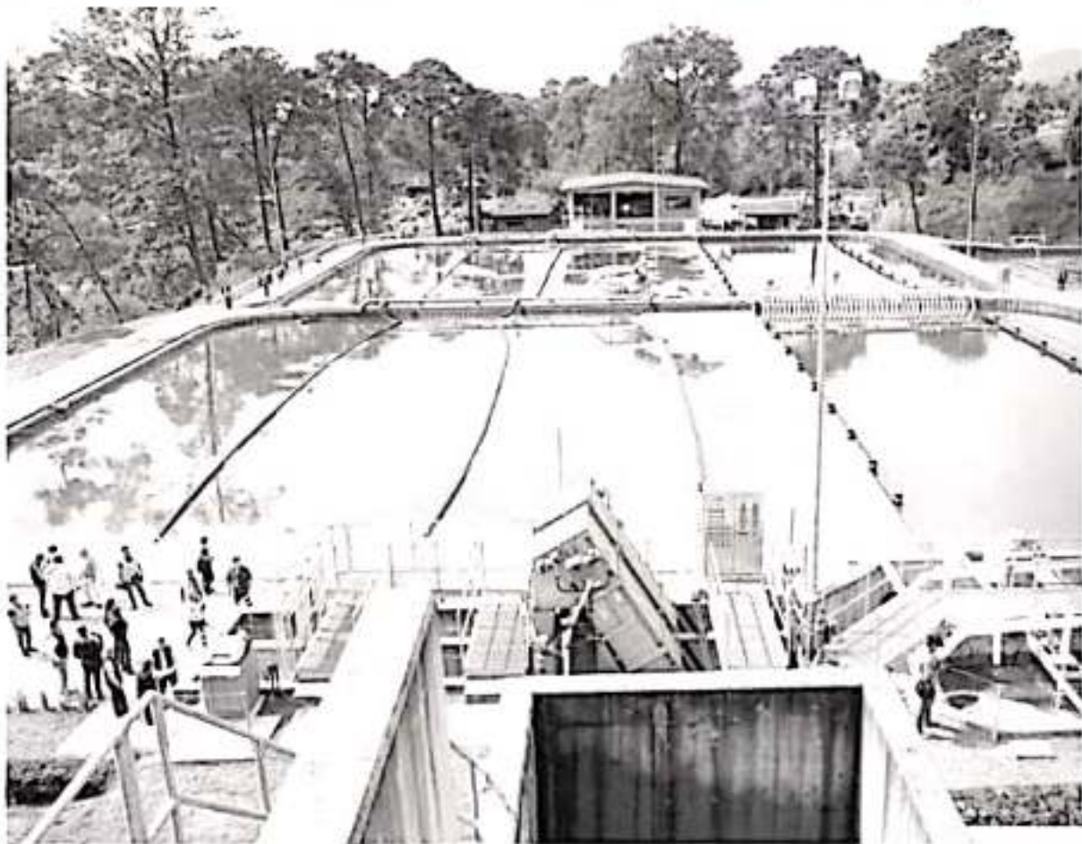
En Michoacán se han construido más obras hídras que nunca, se han realizado más de 700 obras hídras, informó la autoridad estatal.
