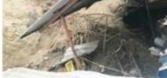
CD. LÁZARO CÁRDENAS, MICH.- Este jueves se registró un deslizamiento de tierra por la presencia de lluvias de los remanentes de la tormenta tropical que está afectando al menos tres viviendas de la zona de Las Guacamayas.
