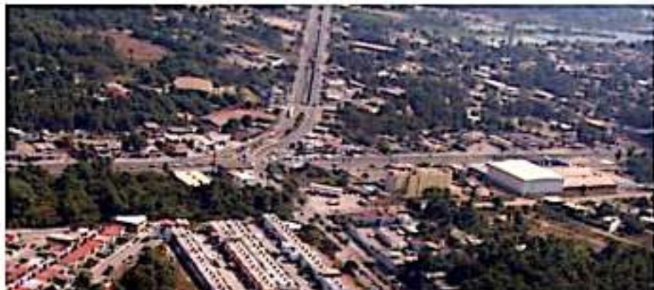
CD. LÁZARO CÁRDENAS, MICH.- Ante los avances para la construcción del distribuidor vial, la administración municipal que encabeza María Itzé Camacho Zapalán inició con los trabajos de notificación a los comercios y retiro de vehículos (con apoyo de Tránsito del Estado) así como la habilitación de las vialidades alternas.
