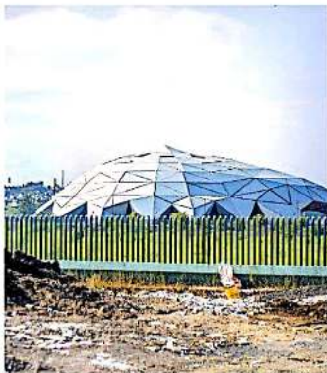
La administración municipal no regula la construcción en dicha zona de riesgo (ARFV)
