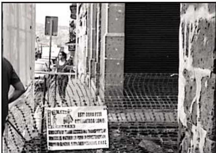
SE PESA PROMESA DE ENTREGAR OBRA EN LA CALLE VASCO DE QUIROGA EN 40 DÍAS, PERO EN LA FECHA
