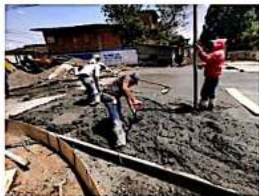
ZAMORA, MICH. - Los trabajos de pavimentación de la calle Ferrocarril, del tramo que corresponde de Murcia hasta Oviedo, lleva un avance del 85 por ciento.
