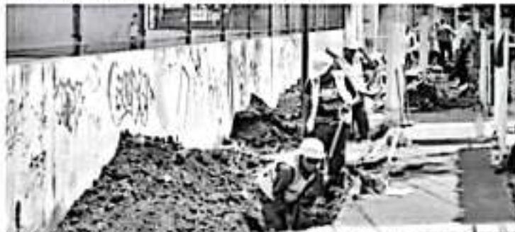
URUAPAN, MICH.- Dicha obra se realiza en coordinación con los vecinos del lugar y lleva un avance del 90 por ciento
