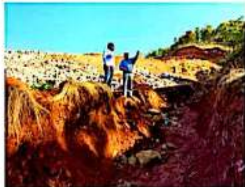
LOS REYES, MICH.- Una brecha cortahegos, también dentro de los trabajos para prevenir incendios.
