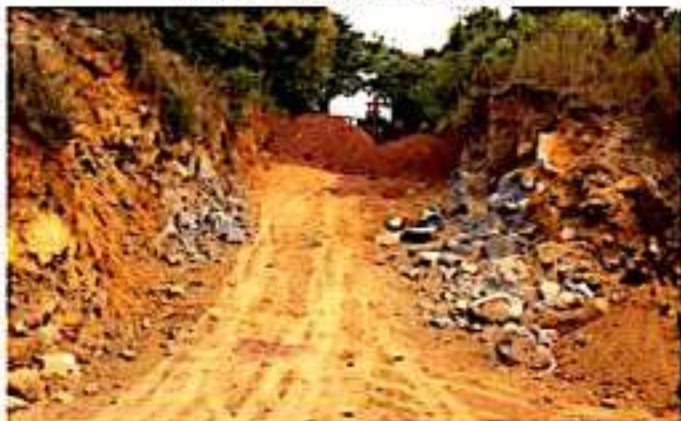
LOS REYES, MICH.- Avanzan trabajos en la calle Lázaro Cárdenas de la comunidad de 18 de Marzo.
