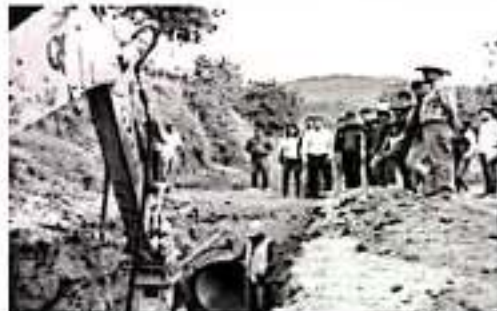
Durante el recorrido, también se verificó la rehabilitación del alcantarillado sanitario de la colonia El Fovissste, en la que se aplica una inversión de 3 millones 306 mil 571.59 pesos.
