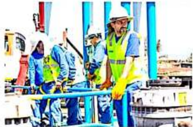
URUAPAN, MICH.- La Capasu realizó labores de mantenimiento a la planta de tratamiento de aguas residuales Santa Bárbara, que le permitirán trabajar al 100% de su capacidad.
