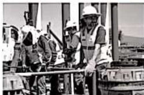
URUAPAN, MICH.- Luego de 20 años de operación de la planta tratadora de aguas residuales "Santa Bárbara" que se localiza al oriente de la ciudad, fue renovado el equipo de bombeo.
