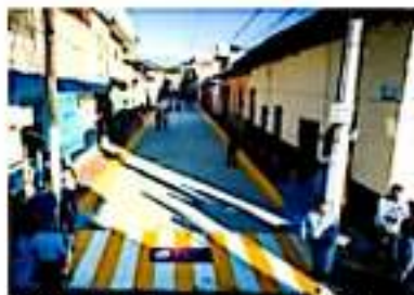
PERIBÁN, MICH.- Concluyeron los trabajos de repavimentación de la calle Zaragoza.
