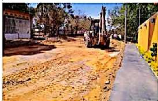
En coordinación con la Jefatura de Tenencia de Caleta de Campos, el ayuntamiento local inició la pavimentación de la calle Libertad de esa demarcación.
