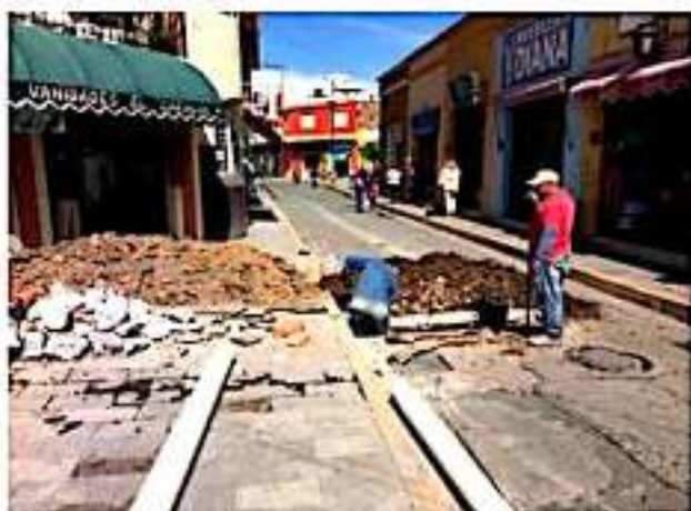
ZAMORA, MICH. - Sobre la calle Guerrero Oriente, se efectuó una importante obra de este tipo.
