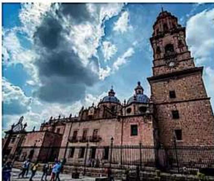
Trabaja se la UNAM a mejorar la estructura de torres de la Catedral de Morelia. | CORFINA
