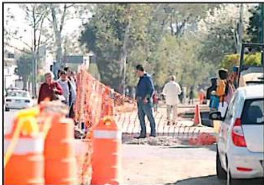
A PESAR DEL CAOS VIAL QUE SE GENERA, DECIDEN SUSPENDIR OBRAS DE REHABILITACIÓN EN MADERO PONIENTE
