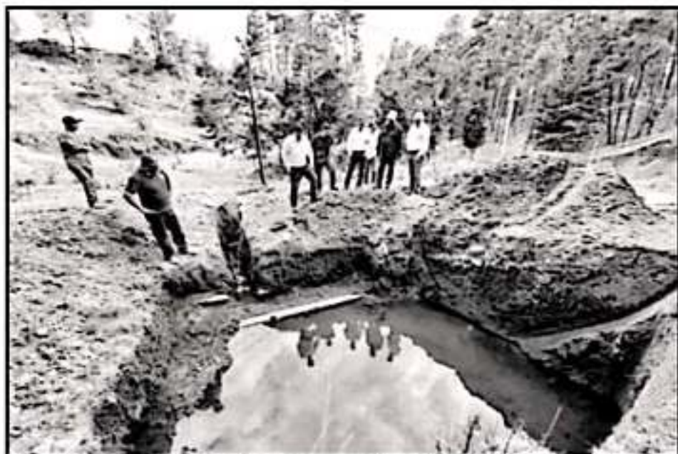
AUTORIDADES DE LA CAPASU REVISAN QUE LOS MANANTIALES Y LA RED DE AGUA ESTÉN EN BUENAS CONDICIONES
