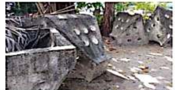
ZIHUATANEJO, GRO.- 100 estructuras de arrecife artificial llevan 11 años generando un foco de infección en el área cercana a la laguna de Las Salinas.
