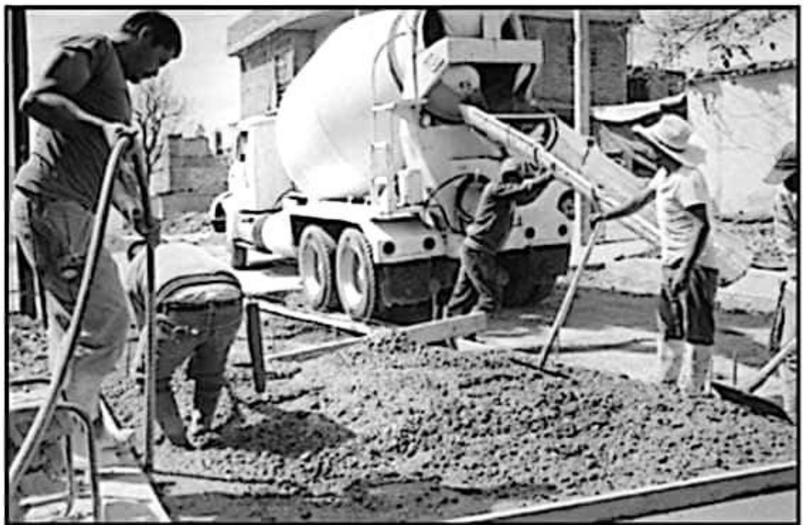
EN TOTAL SERÁN 4 MIL 500 METROS CUADRADOS DE PAVIMENTACIÓN Y MÁS DE 700 EN NUEVAS BANQUETAS.
