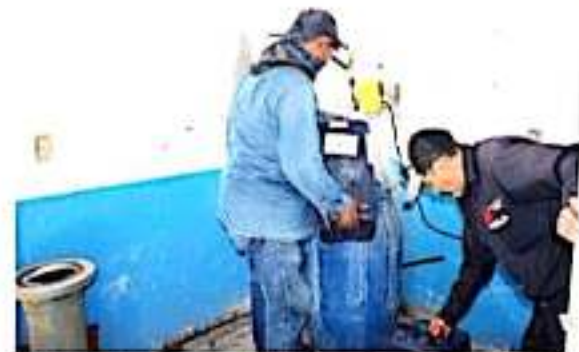
ZAMORA, MICH.- Personal del Sistema de Agua Potable y Alcantarillado de Zamora realiza trabajos de cloración permanente en los 52 sistemas formales de abastecimiento de agua del municipio.
