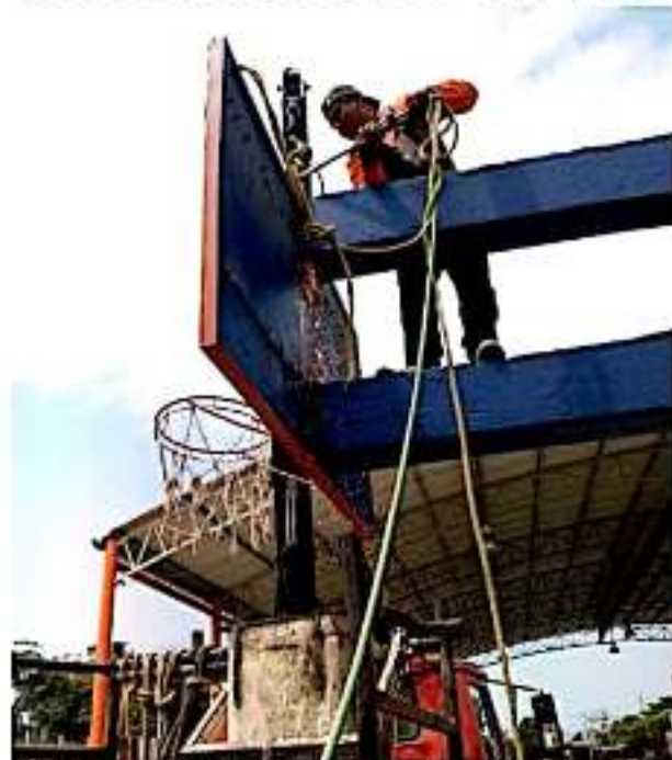
CD. LÁZARO CÁRDENAS, MICH.- La Secretaría de Obras Públicas Municipales avanza en las adecuaciones de la unidad deportiva para habilitarla de cara a la Expo Fiesta 2020, con la finalidad de contar con espacios seguros para la ciudadanía.
