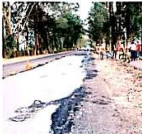
TOCUMBO, MICH.- Se llevaron a cabo trabajos de reparación del tramo carretero Tocumbo-Santa Inés.
