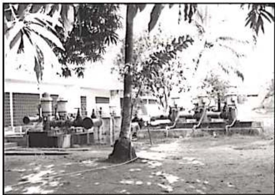
BUSCAN MEJORAR EL SUMINISTRO DEL AGUA POTABLE EN LC CON EL MEJORAMIENTO DE LOS EQUIPOS DE BOMBEO.
