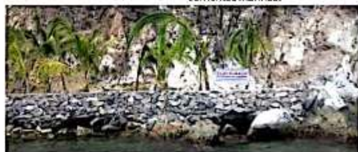
ZIHUATANEJO, GRO.- La Profepa clausuró la obra que un particular realizó en playa Contramar.
