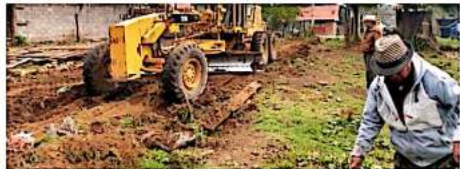
LOS REYES, MICH.- Se llevaron a cabo trabajos de rehabilitación de caminos en las comunidades indígenas de San Luis y San Benito.
