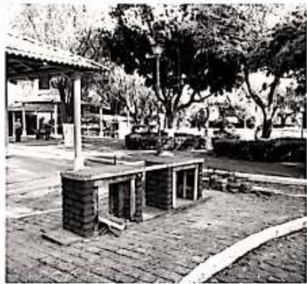
JACONA, MICH.- Es a través del oficial mayor, José Domingo Méndez Gaytán que se supervisan los trabajos a indicaciones de la alcaldesa Adriana.
