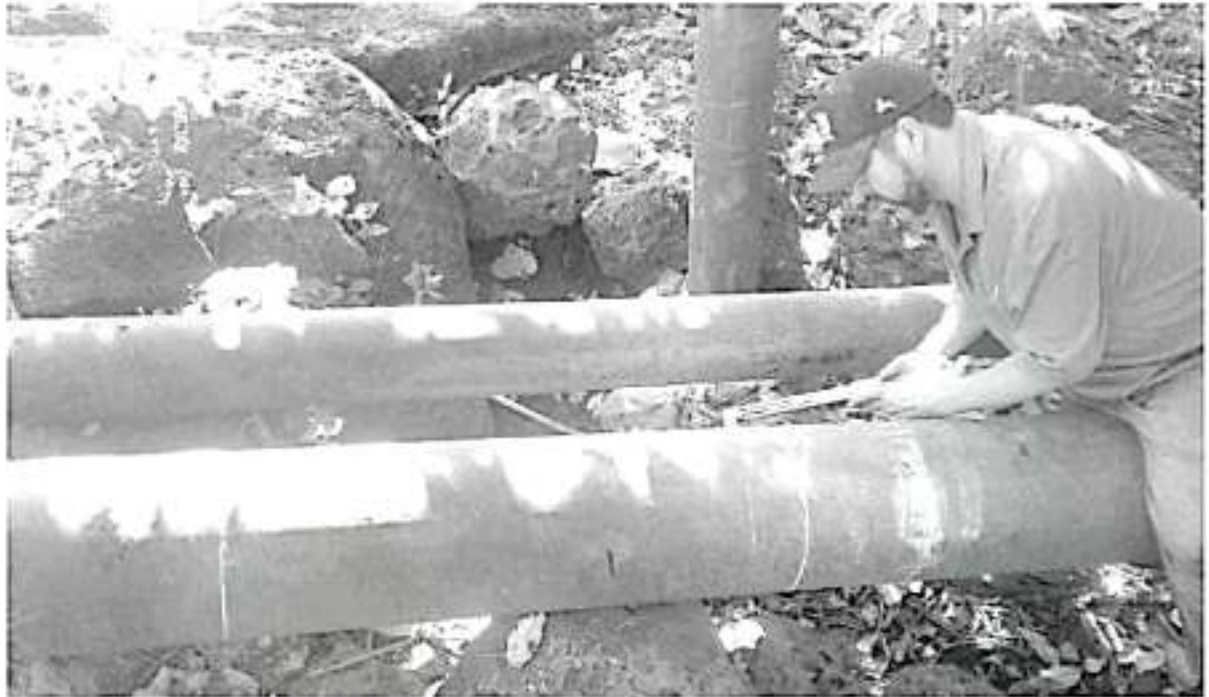
Con un avance físico del 20 por ciento, continúan las acciones para edificar la caseta para equipo de cloración y la entrada y salida del tanque de regularización.
