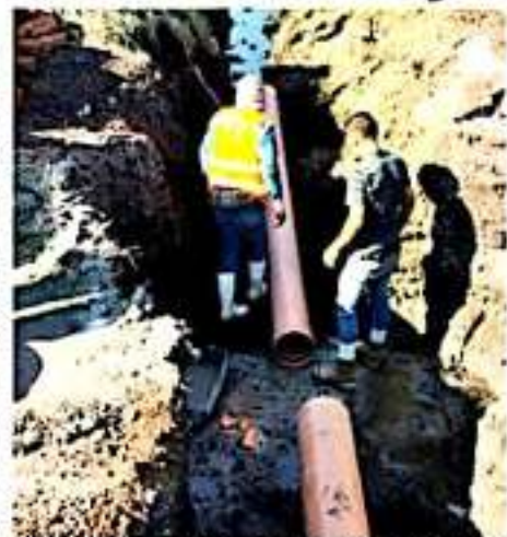
ZAMORA, MICH.- Inician la obra de construcción del colector sanitario en la colonia Primero de Mayo.
