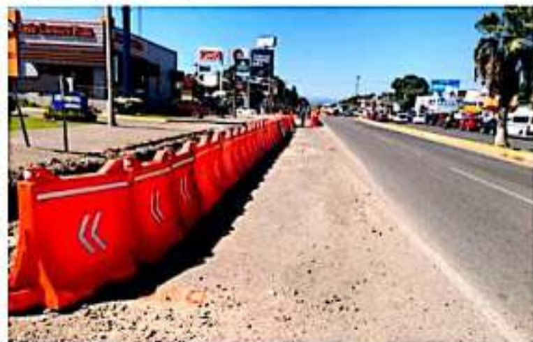
CD. LÁZARO CÁRDENAS, MICH.- Se adecuaron dos espacios para las paradas del transporte público en la avenida Las Palmas, acción con la que se da solución a las peticiones de los grupos transportistas, en el marco a los trabajos de construcción del distribuidor vial.
