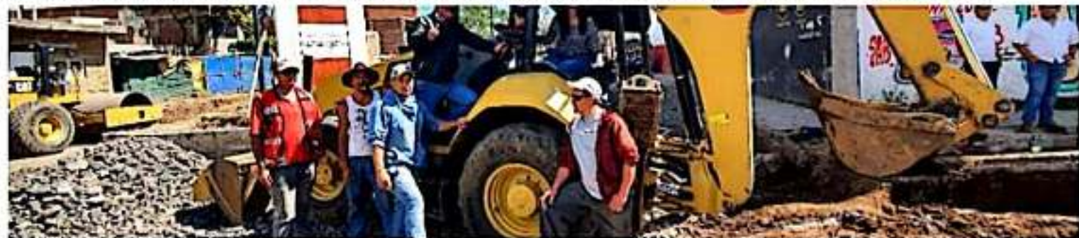
ZAMORA, MICH.- Miguel Aviña García, informó que las labores de este importante proyecto comenzaron con la apertura de caja.
