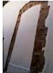
Se trata del marco de una antigua puerta que daba hacia la calle Álvaro Obregón y data del siglo XVII. |COMTSA
