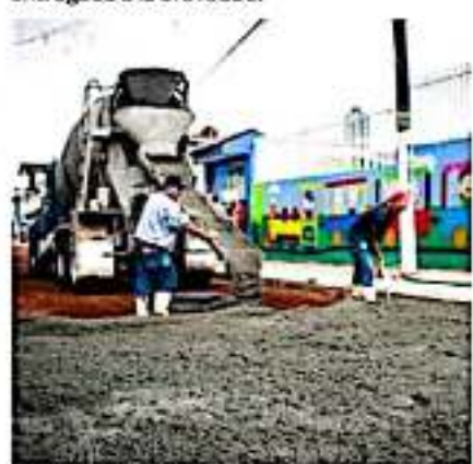
PERIBÁN, MICH.- Por concluir se encuentra la rehabilitación de la calle Zaragoza.
