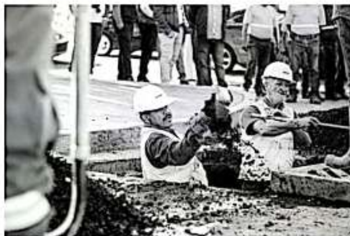
URUAPAN, MICH.- La puesta en marcha de los trabajos, tuvo lugar ayer en la esquina de la calzada Benito Juárez y la calle Michoacán.
