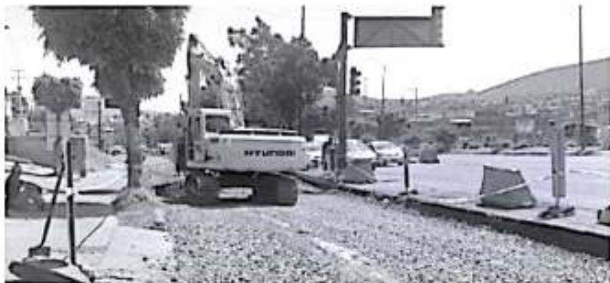
Aspecto del inicio de los trabajos en la Avenida Madero.
