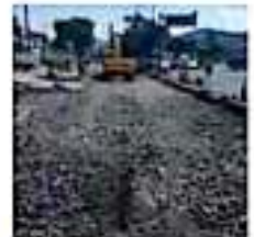
El presidente de CMIC, Michoacán, Jesús Antonio Mazier Contreras, advirtió la escasez de obra al cambio de los pliegos públicos. COMPROBADO
