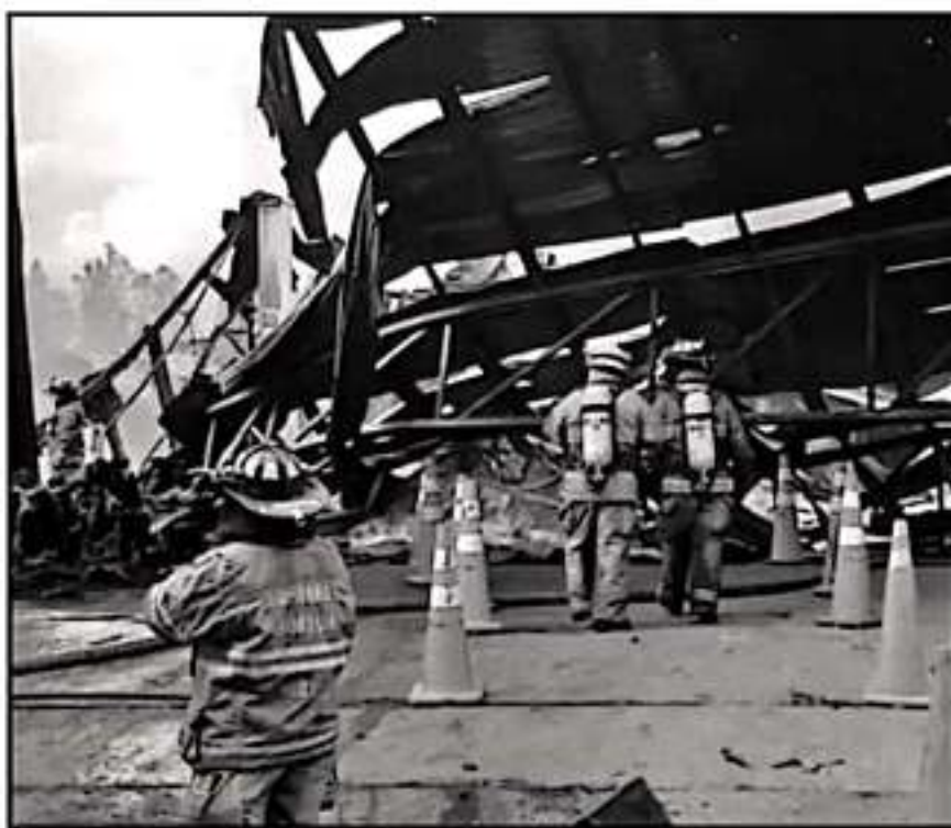
EL ENORME INCENDIO PRÁCTICAMENTE DEJO LA PLANTA DE PLÁSTICOS HECHA ESCUMERO Y FERRO REFORZADO
